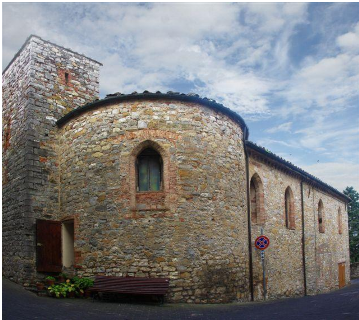
Figura 3 Elaborazione digitale di una foto dell'attuale chiesa parrocchiale in cui si nota chiaramente quel che resta del campanile e dell'abside della vecchia chiesa parrocchiale. Secondo la mappa catastale del 1861 la sacrestia era notevolmente differente dall'attuale.
