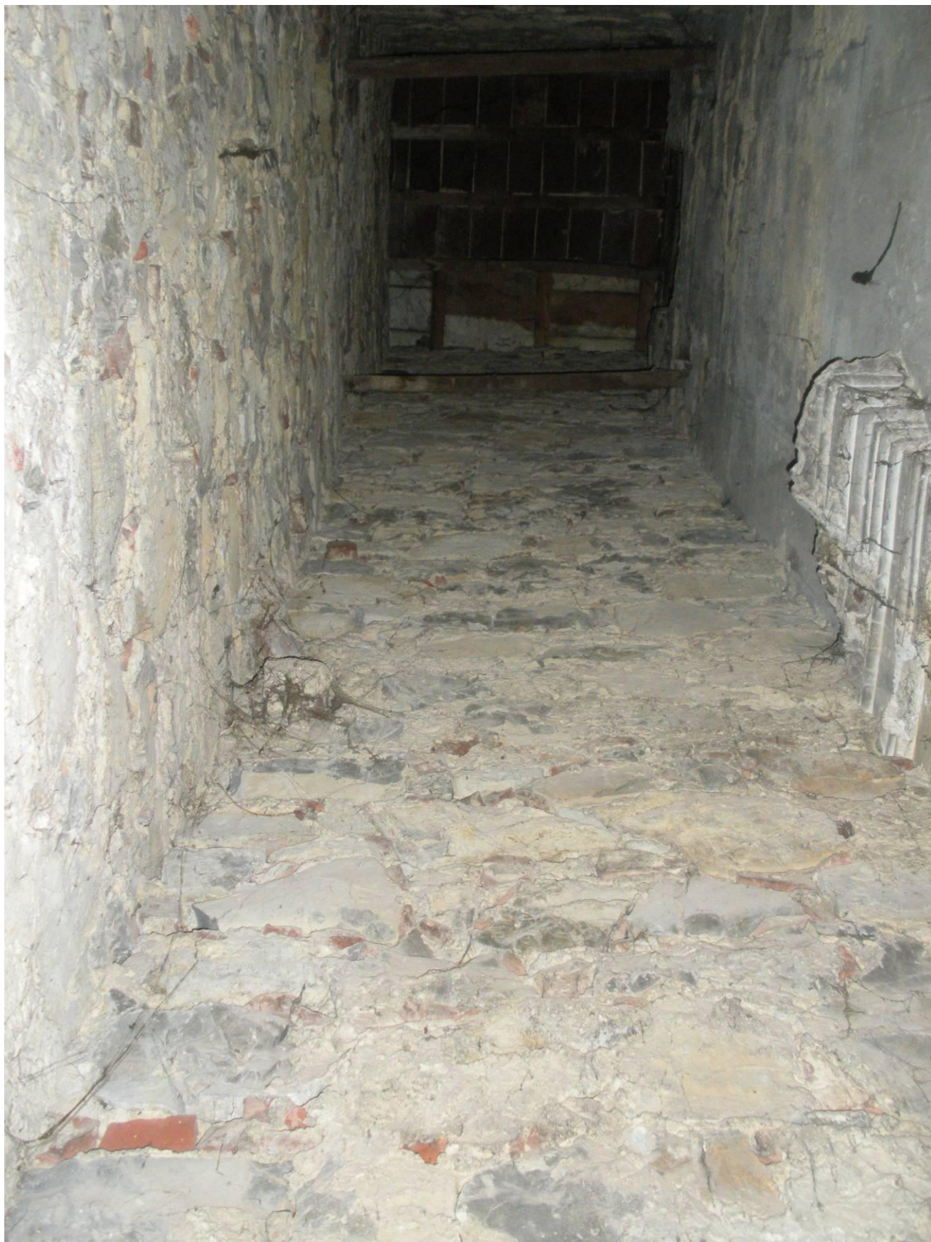
Figura 3 Struttura interna del vecchio campanile. Nella destra il capitello in stucco di figura 3.
