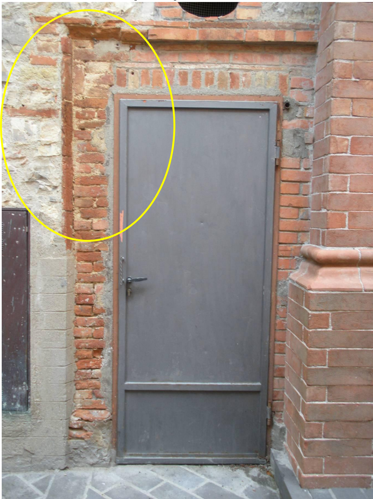
Figura 4 Porta di ingresso dell'attuale campanile. Come si può ben notare i mattoni di sinistra sono molto più vecchi dei mattoni di destra. Questa è ciò che resta della porta principale della vecchia chiesa parrocchiale. All'interno, nella parte sinistra della porta, sono visibili affreschi ocra dello stesso tipo di quelli presenti nel vecchio campanile (fig. 4).
