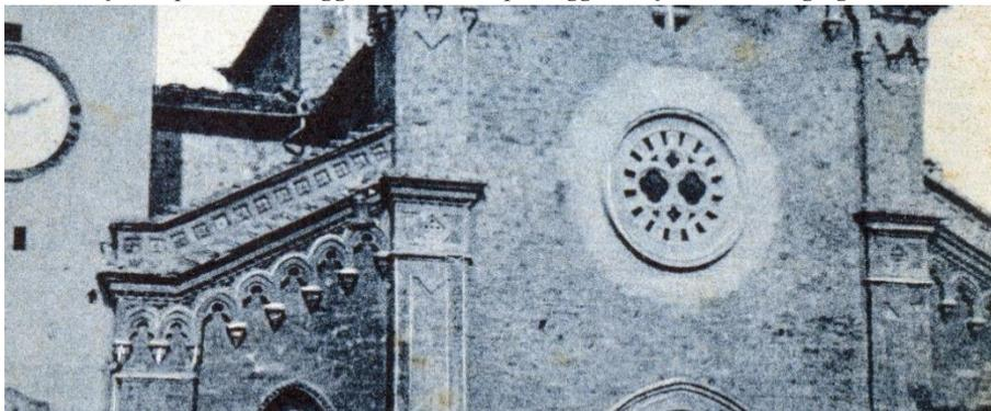
*Figura 4 Dettaglio del rosone appena riparato come si vede dall'alone intorno dovuto ai nuovi mattoni.*
