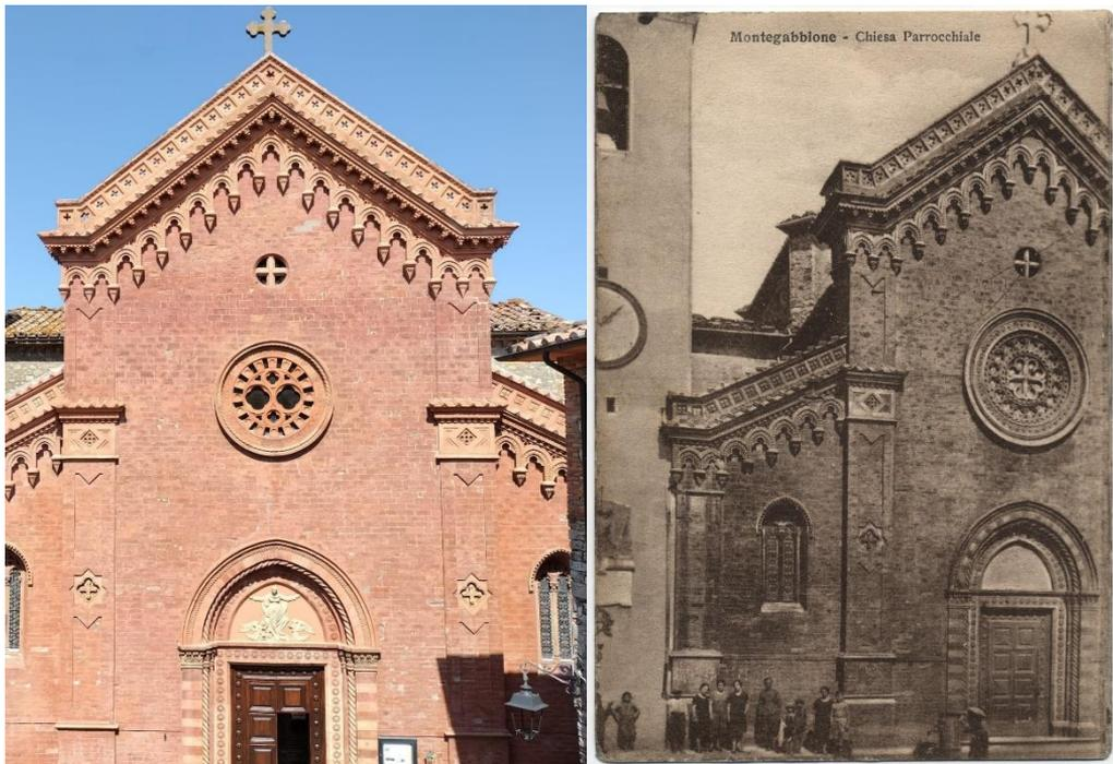
*Figura 3 Un confronto tra la foto attuale ed una cartolina del 1931. Come si nota il rosone è stato modificato perché danneggiato durante il passaggio del fronte del 16 giugno 1944.*
