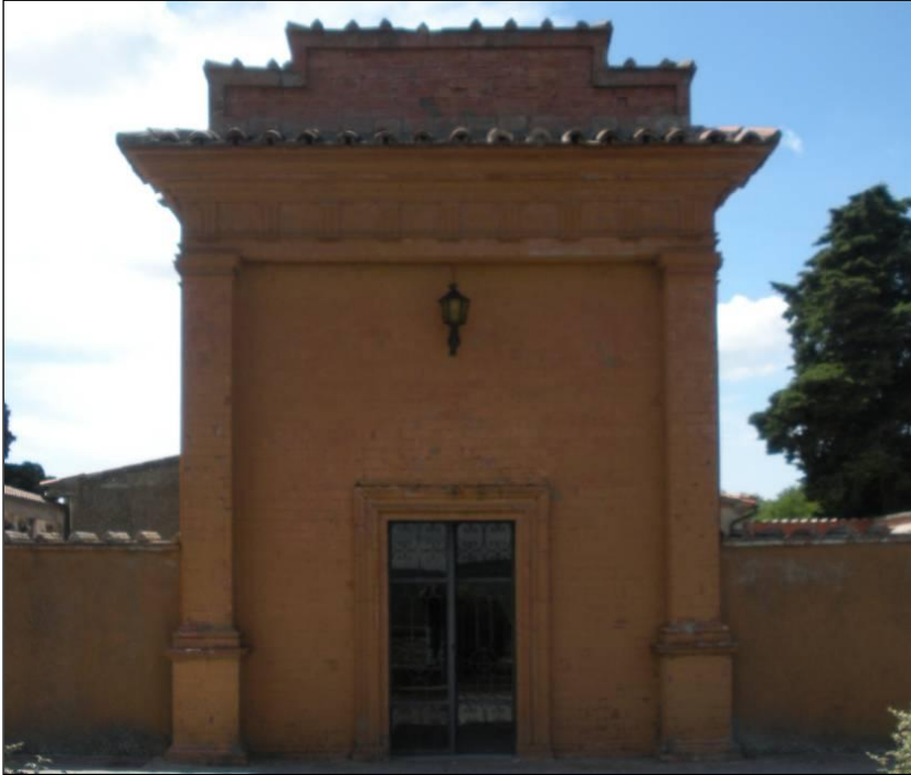
Figura 2 Facciata della chiesa intitolata a S. Giuseppe Labre.
