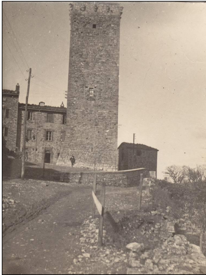
Figura 8 Foto anni '30 della Torre di Montegabbione vista da Est dove si nota un piccolo muro contenitivo probabilmente eretto durante i lavori di costruzione della via Dritta.
